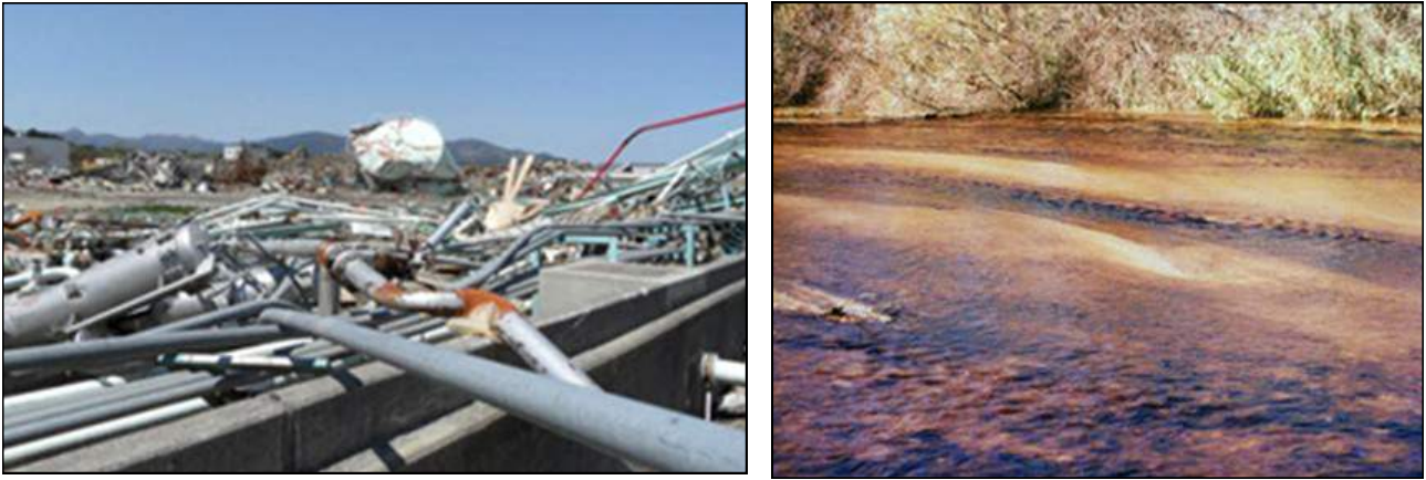
Fig. 34 A,B.- A sinistra: un terminale petrolifero distrutto dal violento terremoto (e associato maremoto) del 2011 in Giappone. A destra: petrolio sversato nel F. Santa Clara in California (USA) dopo il terremoto Northridge del 1994, che ha causato la rottura di un oleodotto interrato, rompendo i giunti su una distanza di 56 km.
