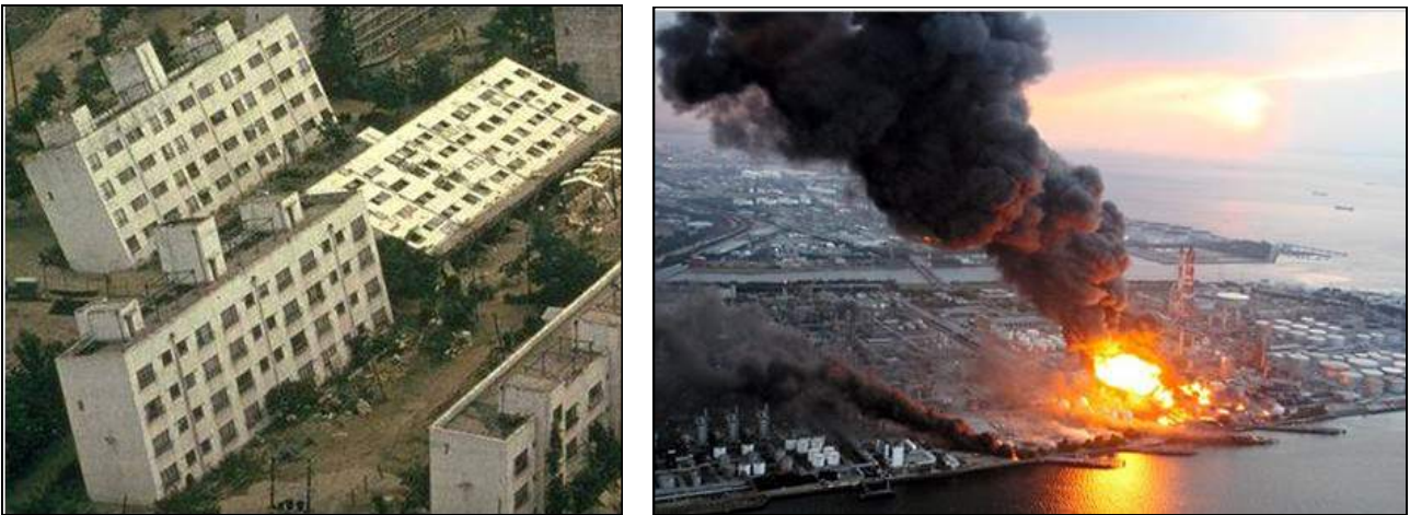
Fig. 35A,B - A sinistra: effetti della liquefazione del terreno a seguito del terremoto di Niigata (Giappone) nel 1964. A destra: raffinerie di petrolio distrutte in Giappone dal violento terremoto del 2011 e dall'associato maremoto-
