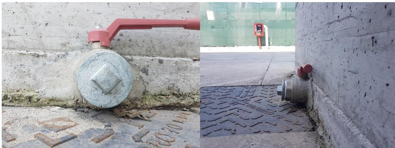
**Figura 3: Valvola di scarico esistente con evidenza dell'installazione di tappo di sicurezza**
