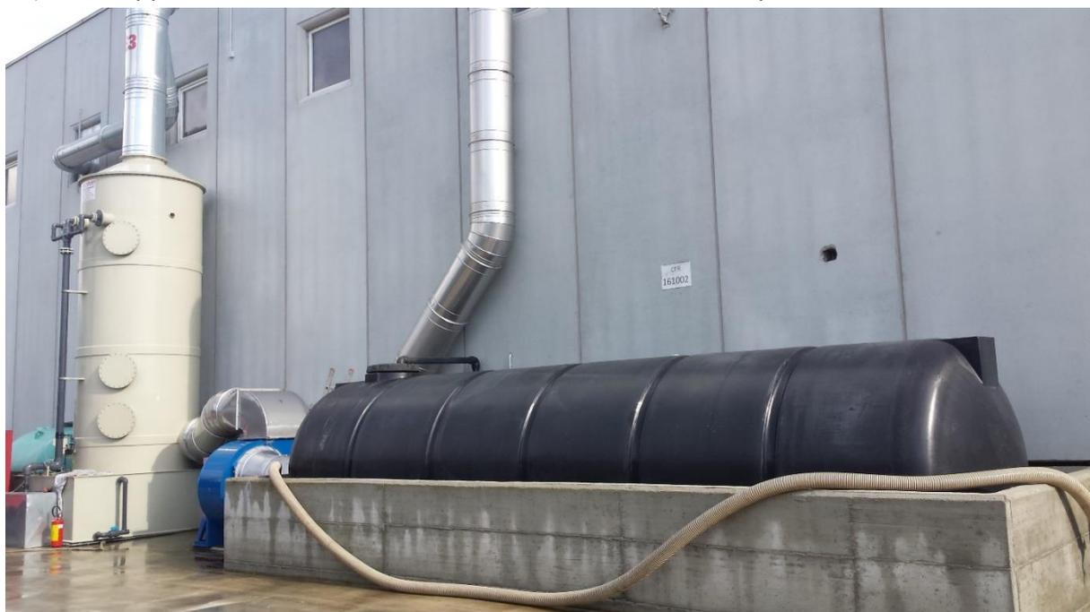
**Figura 2: Cisterna per lo stoccaggio del percolato con bacino di contenimento**
