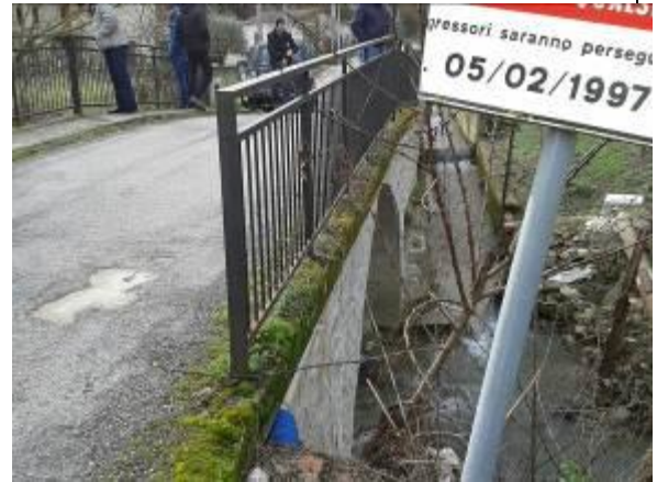
Monitoraggio e istituzione dei cancelli in prossimità del ponte
