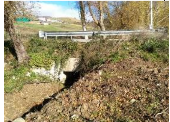
Monitoraggio e istituzione dei cancelli in prossimità dell'attraversamento
