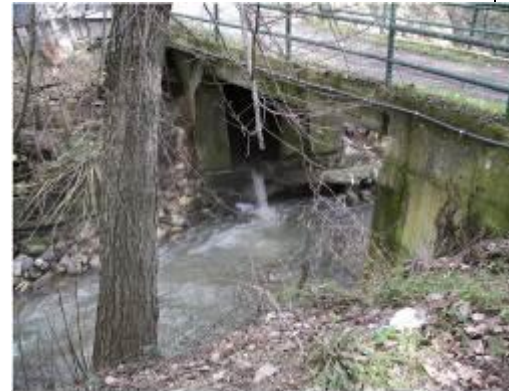
Monitoraggio e istituzione dei cancelli in prossimità del ponte
