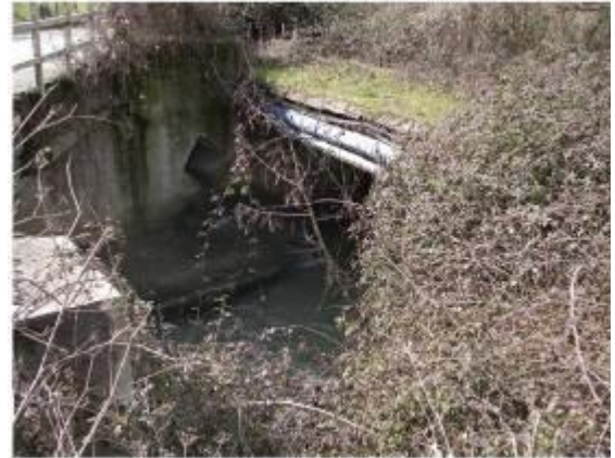
Vecchio ponticello a valle del ponte per la contrada Scarroni
