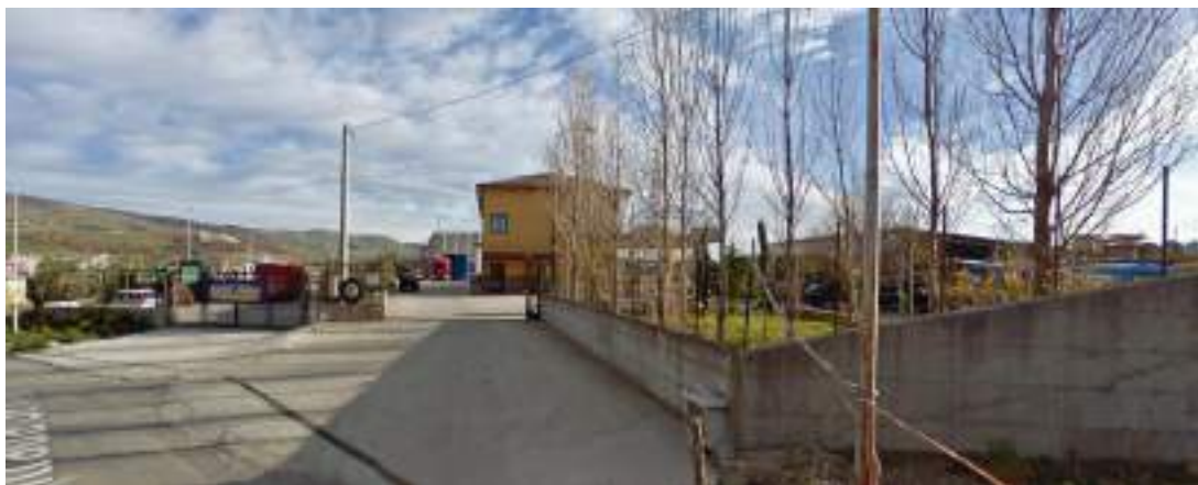
Figura 27: Prospetto officina lato ingresso
