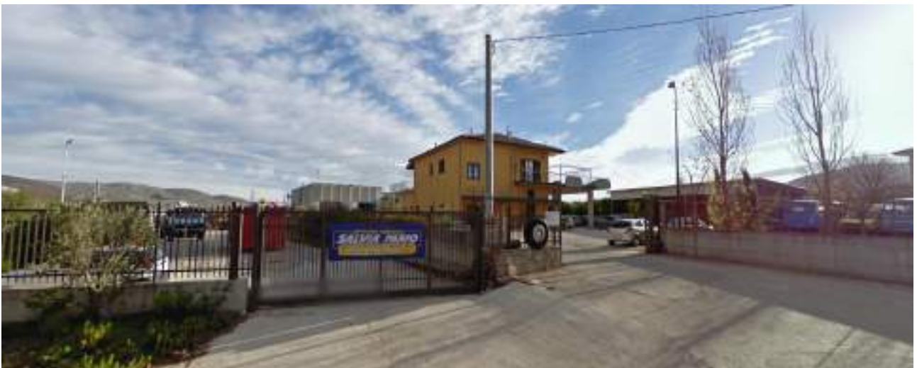
Figura 26: Prospetto officina lato ingresso
