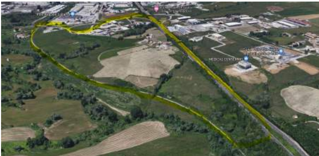
Figura 8: Vista prospettica da Sud dell'area oggetto della variante
